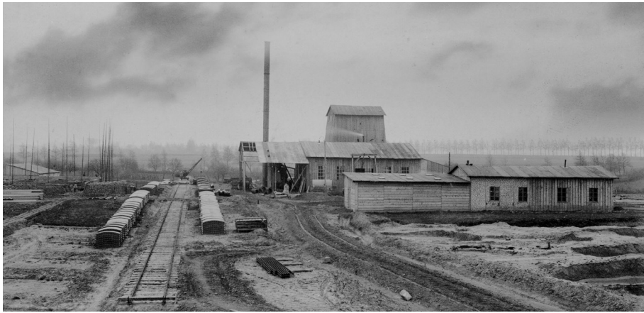
De eerste boortoren op het terrein van de staatsmijn Wilhelmina in aanbouw, 1904. RHCL, fotocollectie DSM.
