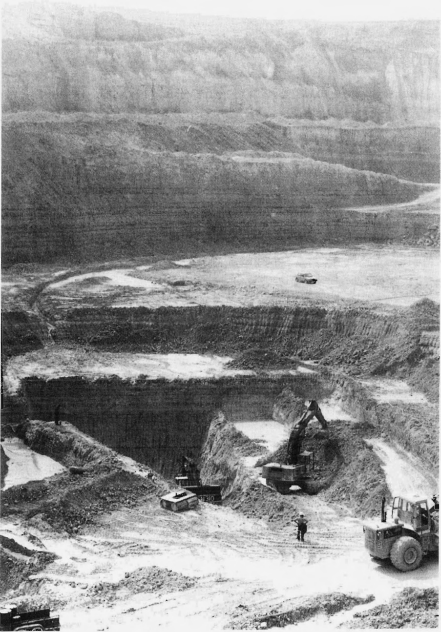
Aanleg van de proefput voor de diepwinning in de ENCI-groeve, ca. 1985. Uit: Van mergel tot cement, 70 jaar ENCI, 1926-1996 (Maastricht 1996).
