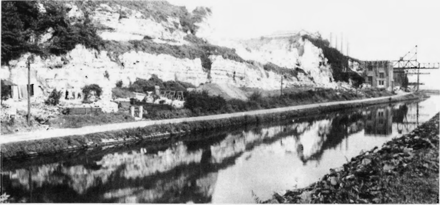
In afwachting van het definitieve besluit over de voorgenomen afgraving van de 'Coulisse', de zijwand van de Sint Pietersberg die de groeve afschermd tegen inkijk vanuit het Maasdal, werd al met de sloop van de huizen onderaan de wand begonnen. Foto ca. 1948. Uit: Van mergel tot cement, 70 jaar ENCI, 1926-1996 (Maastricht 1996).
