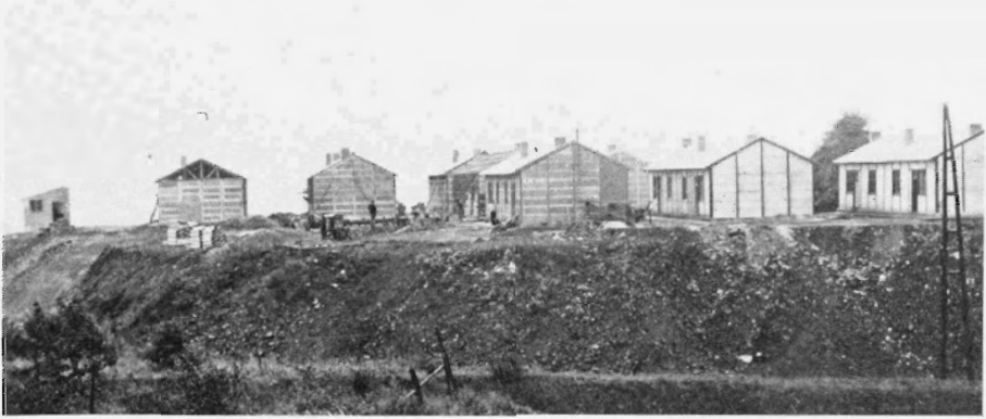
Bouw van het 'Camp Malgarny' in Tilleul voor de opvang van buitenlandse mijnwerkers, 1947-1948. Bron: André de Bruyn, Anciennes Houillères de la Région liégeoise .
