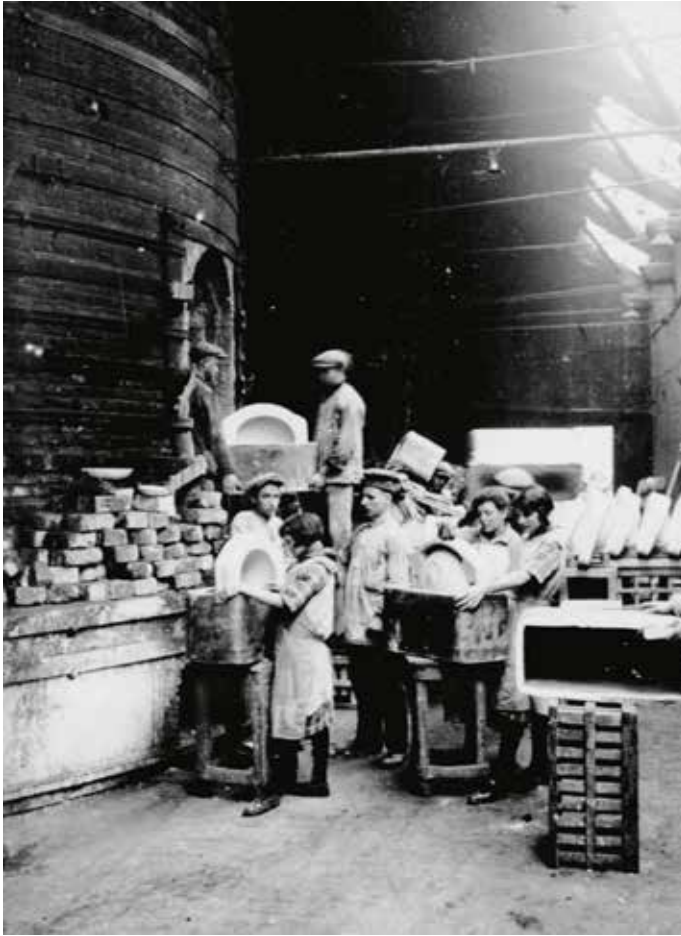
Het vullen van een rondoven met ongebakken sanitair in de aardewerfabriek van Sphinx, ca. 1920. Fotocollectie RHCL.
