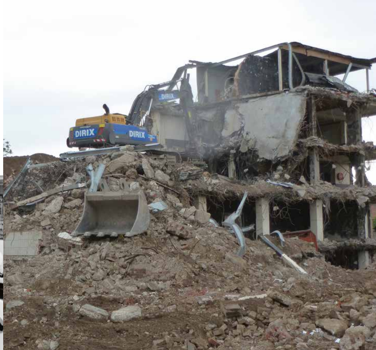
Na tachtig jaar wordt het koelhuis afgebroken. Wat bij de ingebruikname in 1934 een uiterst modern bedrijfsgebouw heette te zijn, was in de jaren 1990 technisch en economisch volledig uit de tijd.
