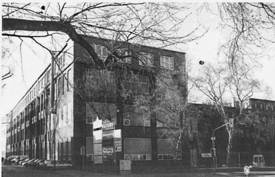
Deutsche Elektrizitäts-Werke zu Aachen - Garbe, Lahmeyer & Co. - Aktiengesellschaft, Jülicher Straße 191. Fotocollectie N.Gilson.
