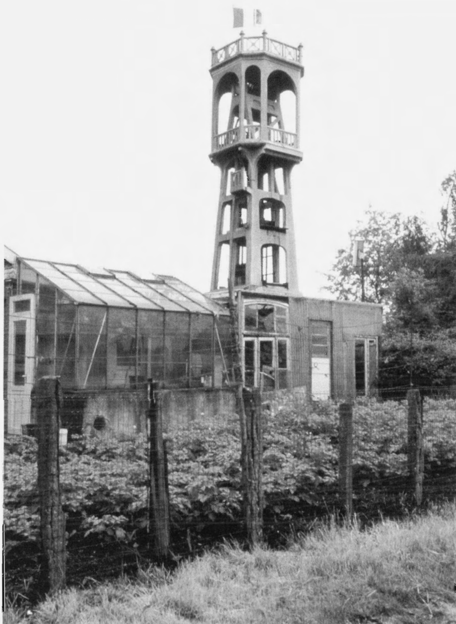
Luchtschacht, Belle Fleur of Tour de Hoignée geheten. Foto H. Wijenberg (SHCL). Deze luchtschacht, opgetrokken in beton, dateert uit 1927. De toren, strategisch gelegen boven op het plateau, met uitzicht op het Maasdal, is op 10 mei 1940 door het Belgische leger opgeblazen, om te voorkomen dat de oprukkende Duitse troepen het bouwwerk zouden gebruiken om de Belgische stellingen langs de Maas onder vuur te nemen. Na de oorlog is de toren in de oorspronkelijke staat hersteld. Sinds 1992 is het een geklasseerd monument, dat onder auspiciën van de gemeente Visé helemaal is gerestaureerd.
