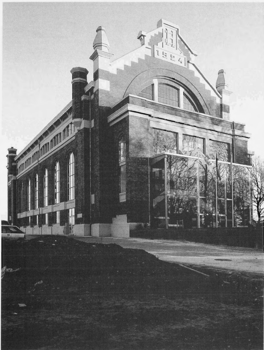
Zicht op de gerestaureerde en herbestemde voormalige elektrische centrale (1924) van Zolder die nog duidelijk in een prestigearchitectuur gebouwd werd. Na de brand van 1925 zal men goedkoper bouwen. Sinds december 2000 wordt het gebouw betrokken door het Europees Centrum voor Restauratietechnieken en wordt er geen elektriciteit maar vakkennis en vakkunde voor de sector van de bouw en de monumentenzorg geproduceerd. Foto PCCE: Bert Van Doorslaer.
