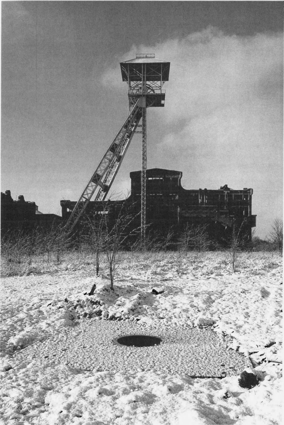
De mijn André Dumont in Waterschei. Winters beeld van de beschermde en inmiddels gerestaureerde schachtbok II. Het putdeksel vooraan is nog wat rest van schacht I. Verzameling PCCE : foto Bert Van Doorslaer, 2002.
