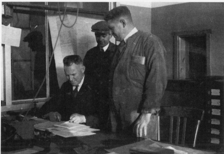
De heer J. van der Linde met twee bazen aan zijn bureau in het fabriekskantoor op de zesde verdieping van Nitraatfabriek I, 1936. Fotocollectie W. van der Linde.
