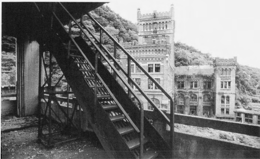
Op een van de verdiepingen van schachttoren nr. 3. Foto H. Wijenberg (SHCL).
