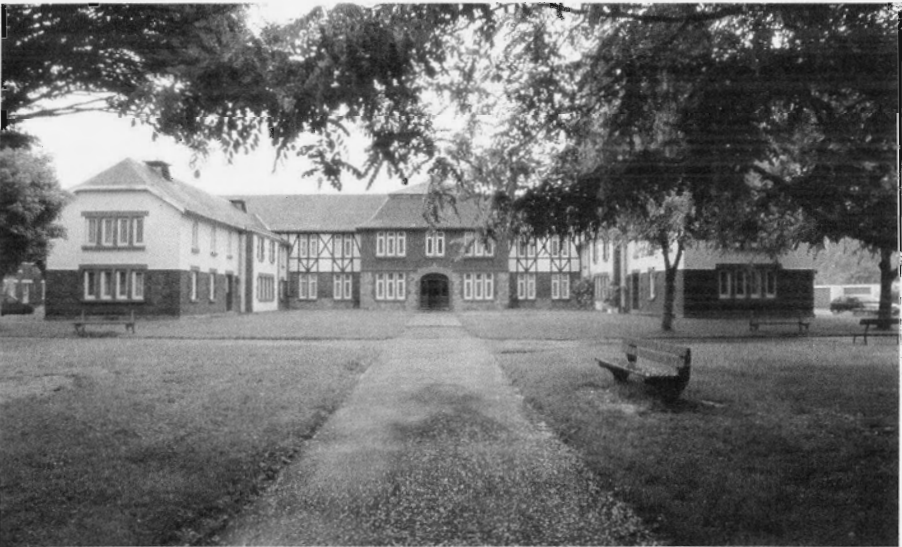
Tuinwijk of cité jardin te Cheratte, aangelegd in 1925. Foto H. Wijenberg (SHCL). De wijk is in de jaren 1980 gerenoveerd in opdracht van woningstichting La Régionale visétoise d'habitations. Van het oorspronkelijke complex zijn 42 woningen gesloopt, 222 woningen zijn gerestaureerd, het gezellenhuis met 220 kamers is thans een gebouw met 22 appartementen.
