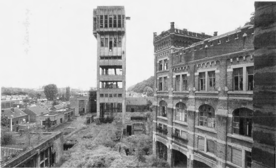
Op de achtergrond de betonnen schachttoren nr. 3. Foto H. Wijenberg (SHCL).
