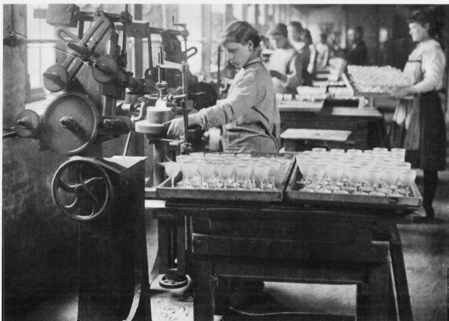
Versieringen op de kelk van wijnglazen worden aangebracht met behulp van een guillocheermachine, die lijnpatronen kraste in een met was bedekt glas.
