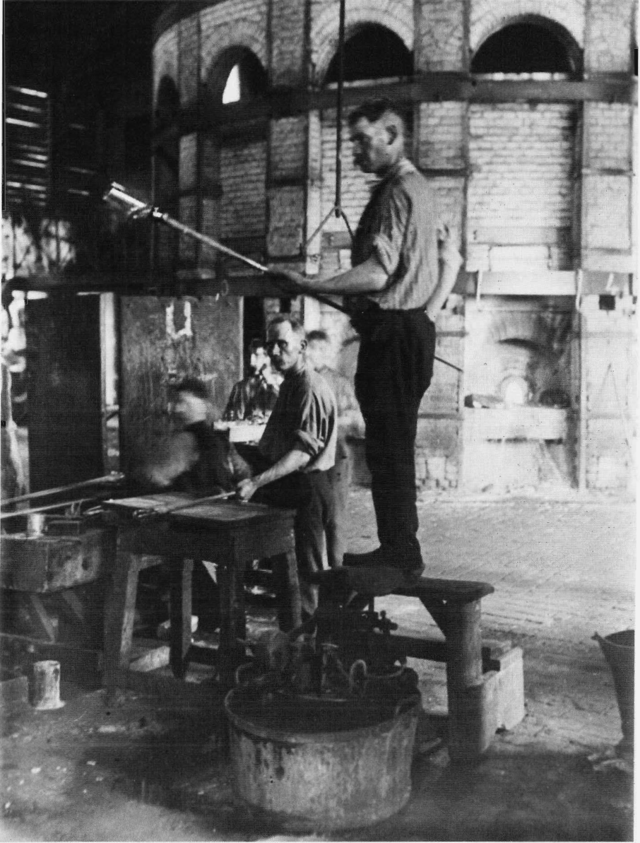
Het glazen voorwerp is gevormd. Op de achtergrond is glassmeltoven nr. 4 van het type Boëtius goed te zien.
