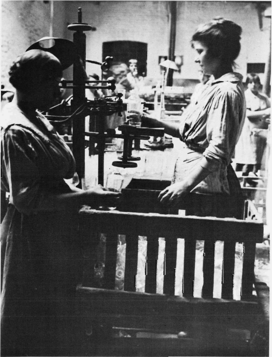
De vrouw links houdt een drinkglas gereed voor haar collega rechts, die het glas met behulp van een snijmachine aan de zijkant horizontaal insnijdt zodat er een geopende bovenzijde ontstaat.
