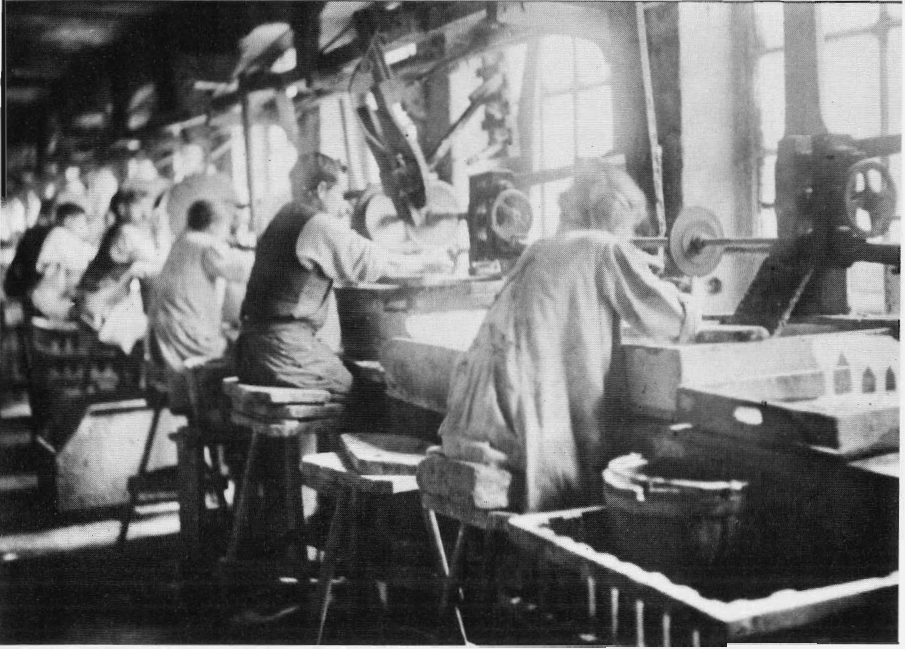
Met behulp van verticale roterende slijpstenen worden kristallen drinkglazen, karaffen, vazen en andere kristalglasproducten bewerkt. Het effect van de bewerking kon bij daglicht het beste worden beoordeeld.
