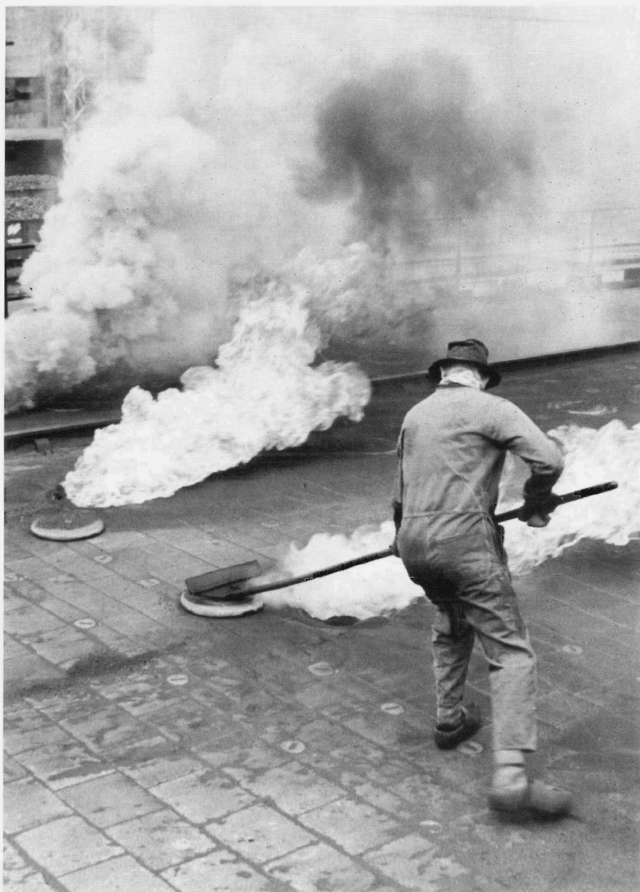
Het afdekken van de putten bij de cokesovens. Foto ca. 1957 (coll. SHCL, archief GSL).
