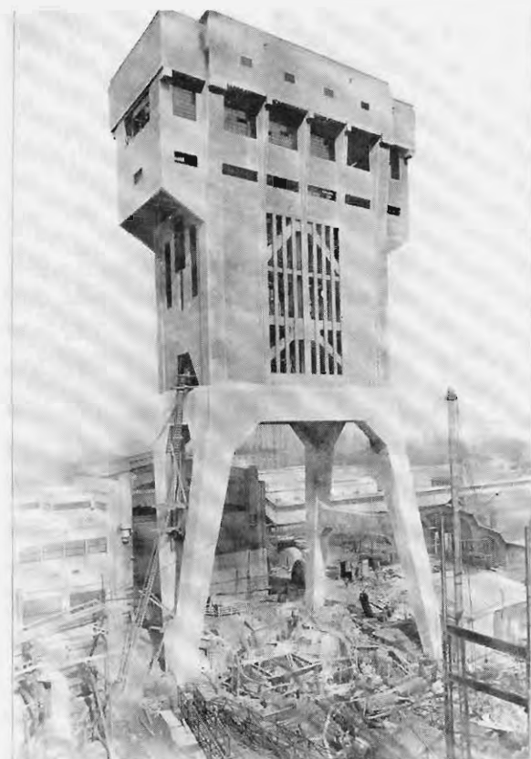
Fig. 18. Schachtbok van schacht 1 op staatsmijn Maurits. De ophangmachines van het gebouw boven op den hef ondergebracht. De steunconstructie op den voorgevel is het begin van den toelooer en de kolentoren en staat thans aan het open gelycke van het gebouw op den achtergrond. Hoogte 56 M.
